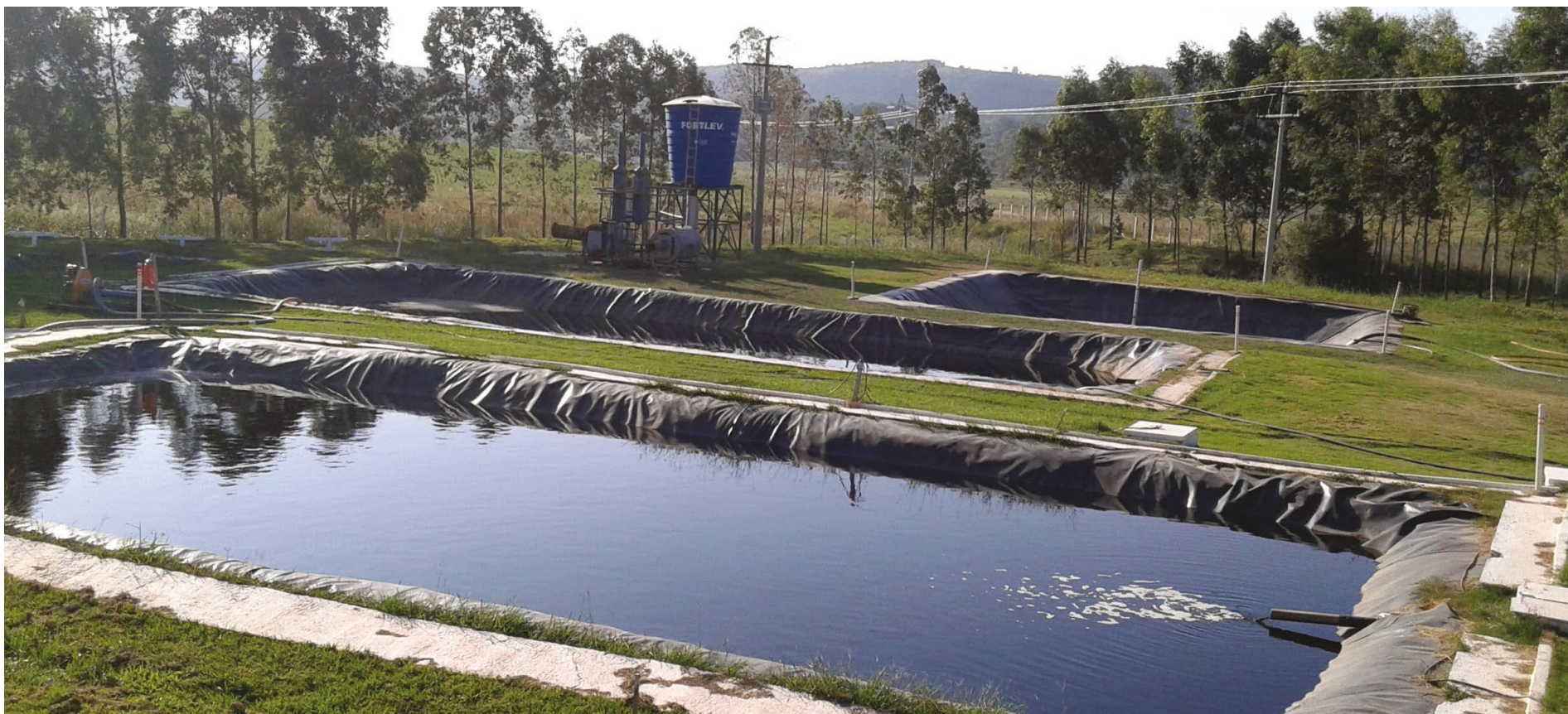
Tanque de acumulação de chorume
